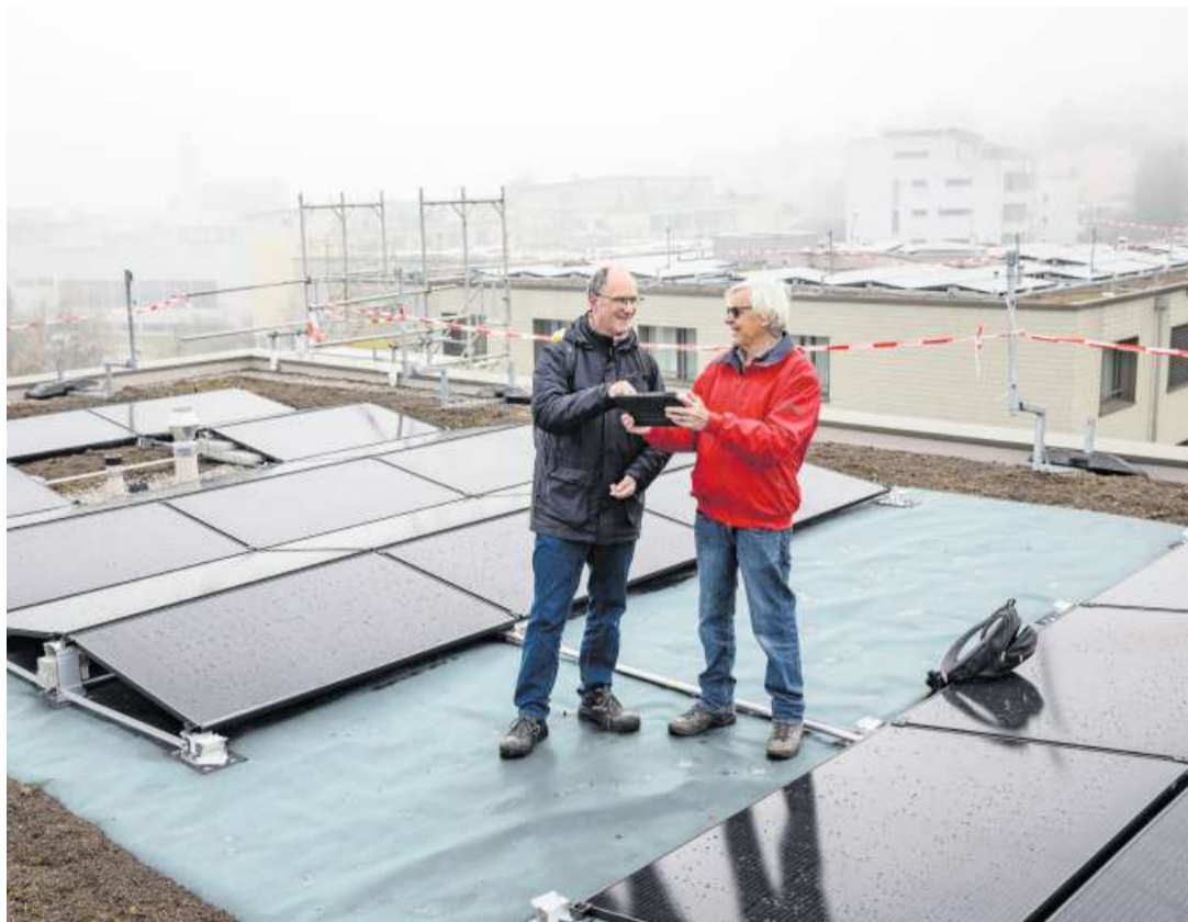
Peter Kocher (links) und Kari Kuhn auf einem der Dächer mit neuer Photovoltaikanlage am Zentrumsweg in Adligenswil.
